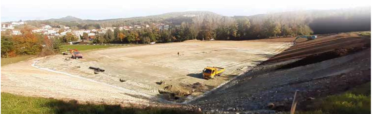
Le lot 2, confié à l'entreprise TERIDEAL, consiste en la réalisation du drainage de surface, la mise en œuvre de la surface de jeux synthétique avec remplissage liège, la pose des équipements. Il sera entrepris suivant les conditions météo en fin d'hiver.
