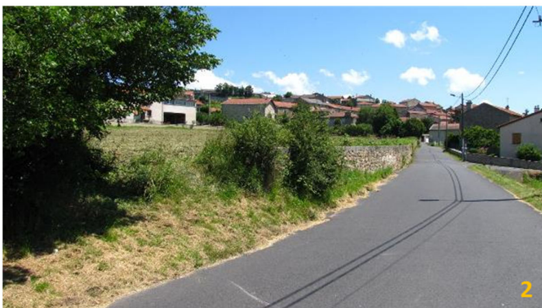
Figure 79 - Localisation et vue de la zone, rue des Vios
