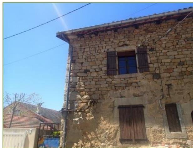
**Photographies 54 et 55 – A gauche et à droite : Maison en pierre dans le centre-bourg comportant des anfractuosités – Centre-bourg(04/05/2016)**
